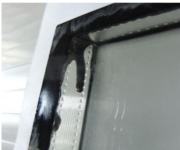
Slika 13.1.7., Tipične greške kod korištenje nekompatibilnih materijala u kombinaciji jedan sa drugim
