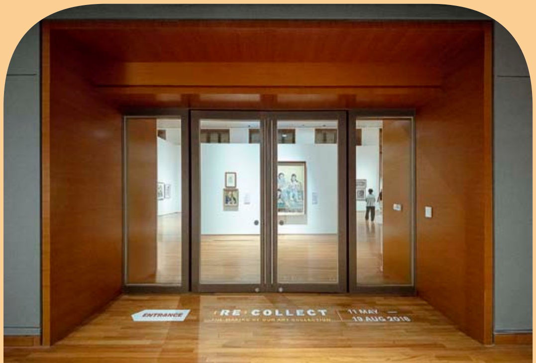
Ovješena fasada s Pilkington Pyrostop ® – Fulton Center, New York (SAD)
